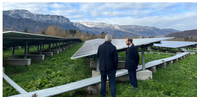
Visite d'une centrale photovoltaïque - Faverges - 25/11/22
